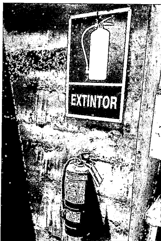
EXTINTOR EN OBRA
