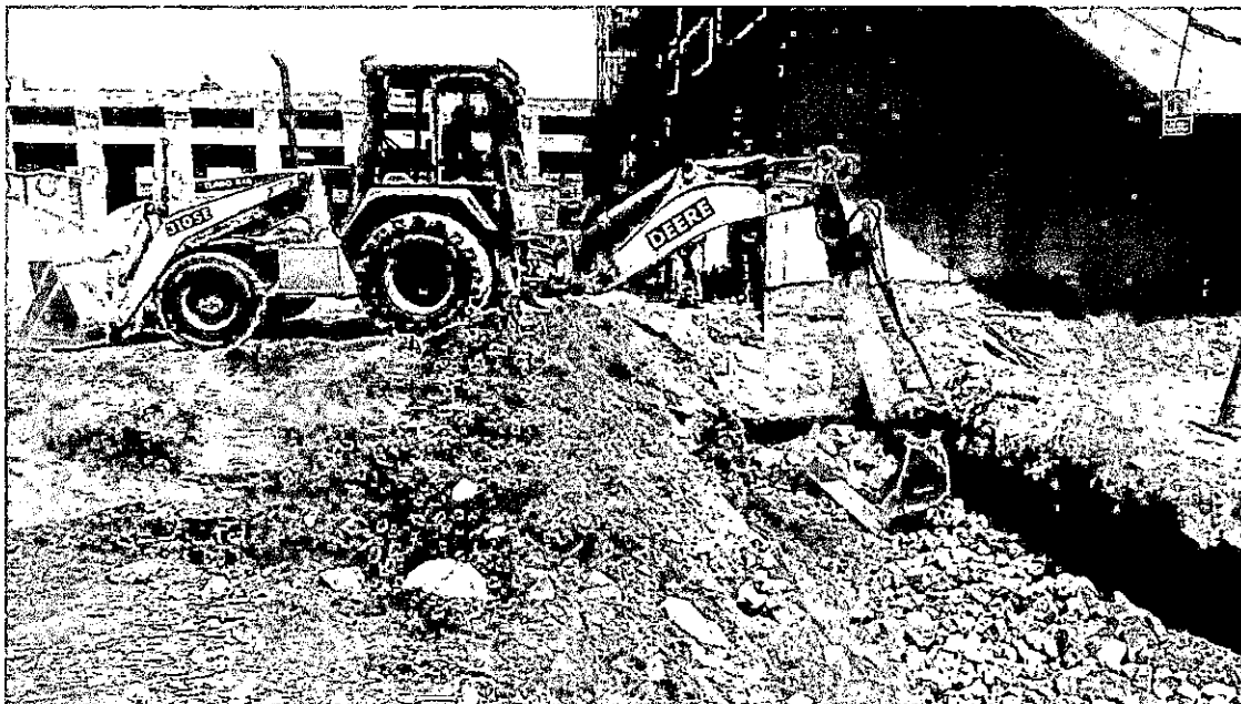
EXCAVACION PARA LA CIMENTACION DE CERCO
